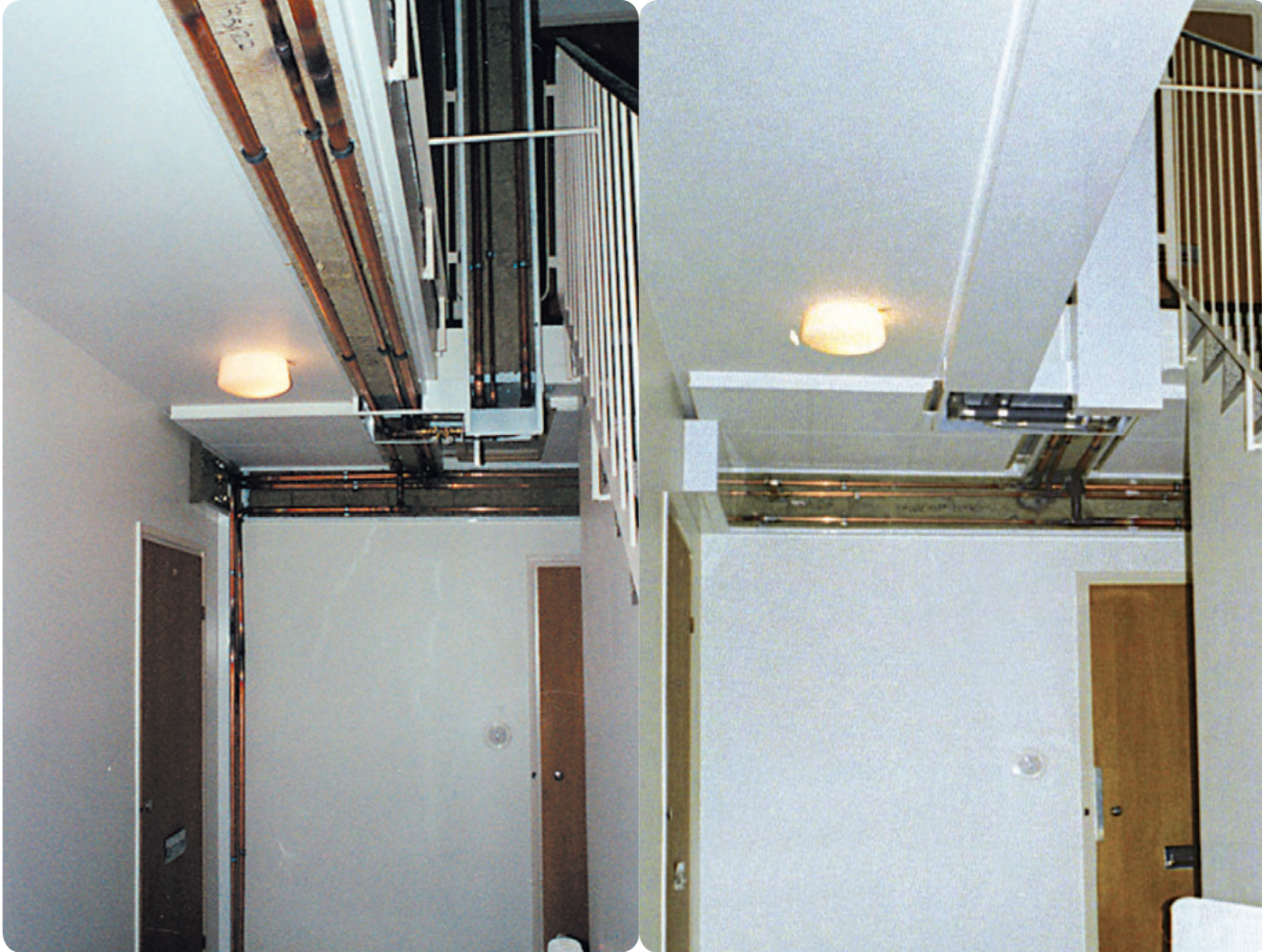
Elementtien avulla on helppoa ja nopeaa tehdä suuret ja vaativatkin putkiston perusparannustyöt. Putket piiloutuvat näkymättömiin valmiin kansiosan asennuksen jälkeen.
