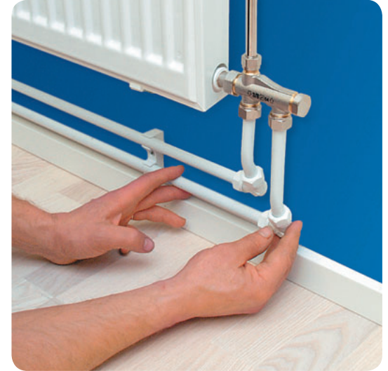
Kupariset lämpöjohdot ovat kooltaan pieniä ja joustavia asentaa.
