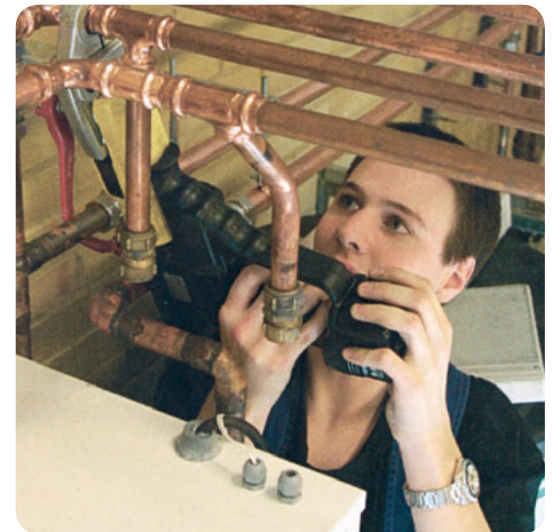
Puristettavat liitokset tehdään ilman tulitöitä. Kuparijärjestelmät on mahdollista asentaa kokonaisuudessaan myös tällä tavoin – selkeä etu peruskorjauksessa.
