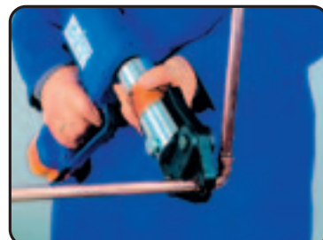
Puristimen leuat tekevät liitoksesta ehdottoman tiiviin ja siistin.
